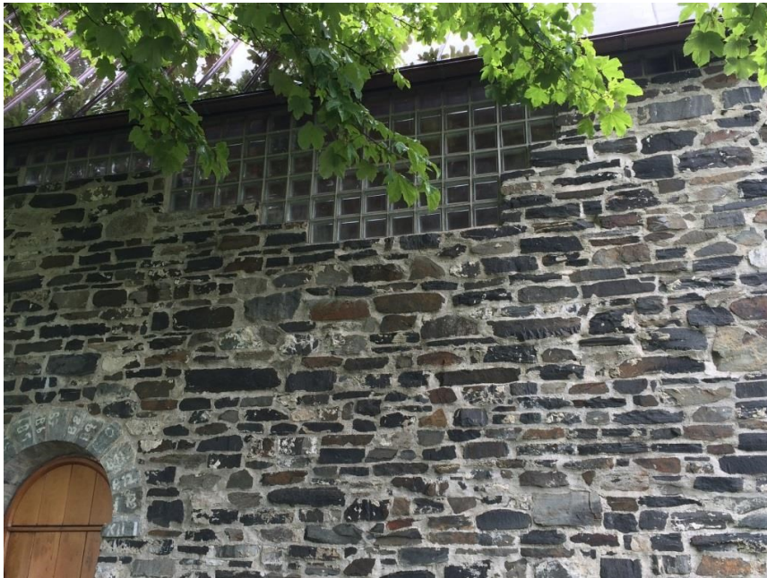
Figur 1 Ruinkirken på Sola hvor «mursteinene» i glass kan skimtes mot takrøstet.
