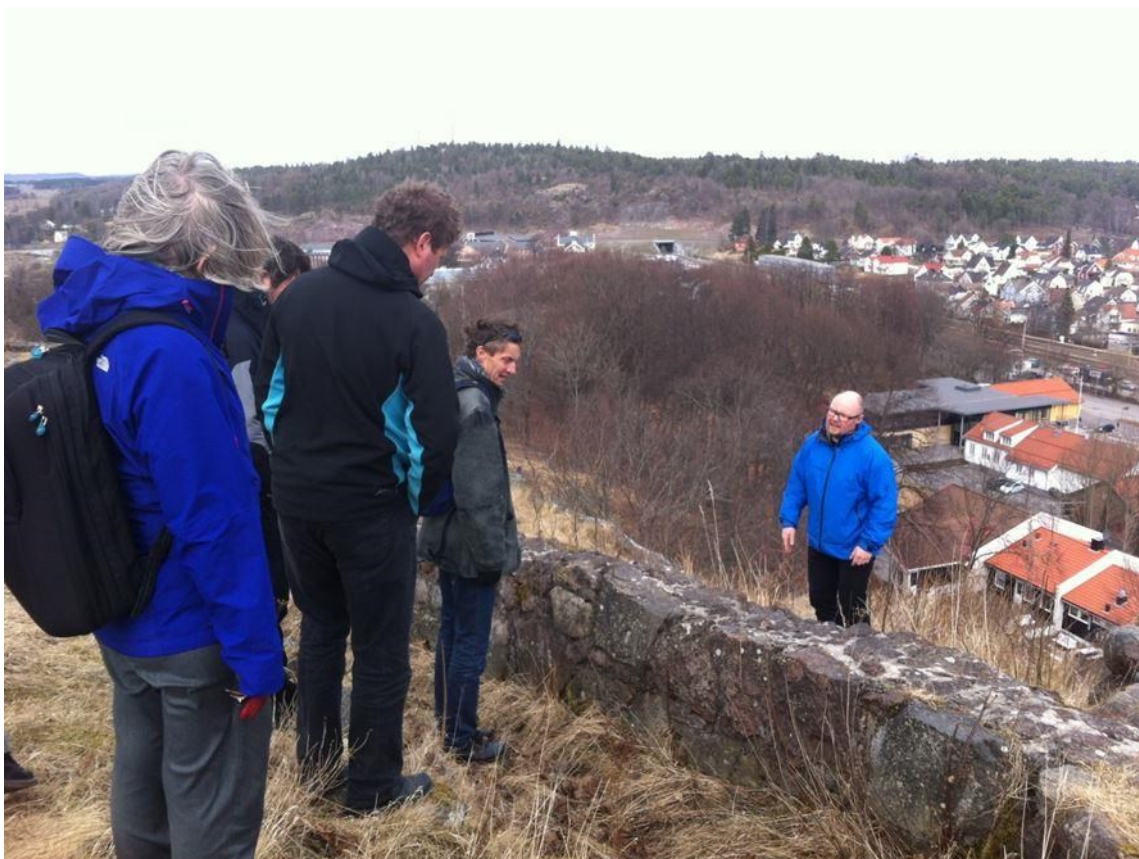
Figur 7 Ringmuren på Slottsfjellet slik den fremtrer i et parti mot øst i dag. Det som er synlig mur er for det meste Fischers påmurte rekonstruksjon.
