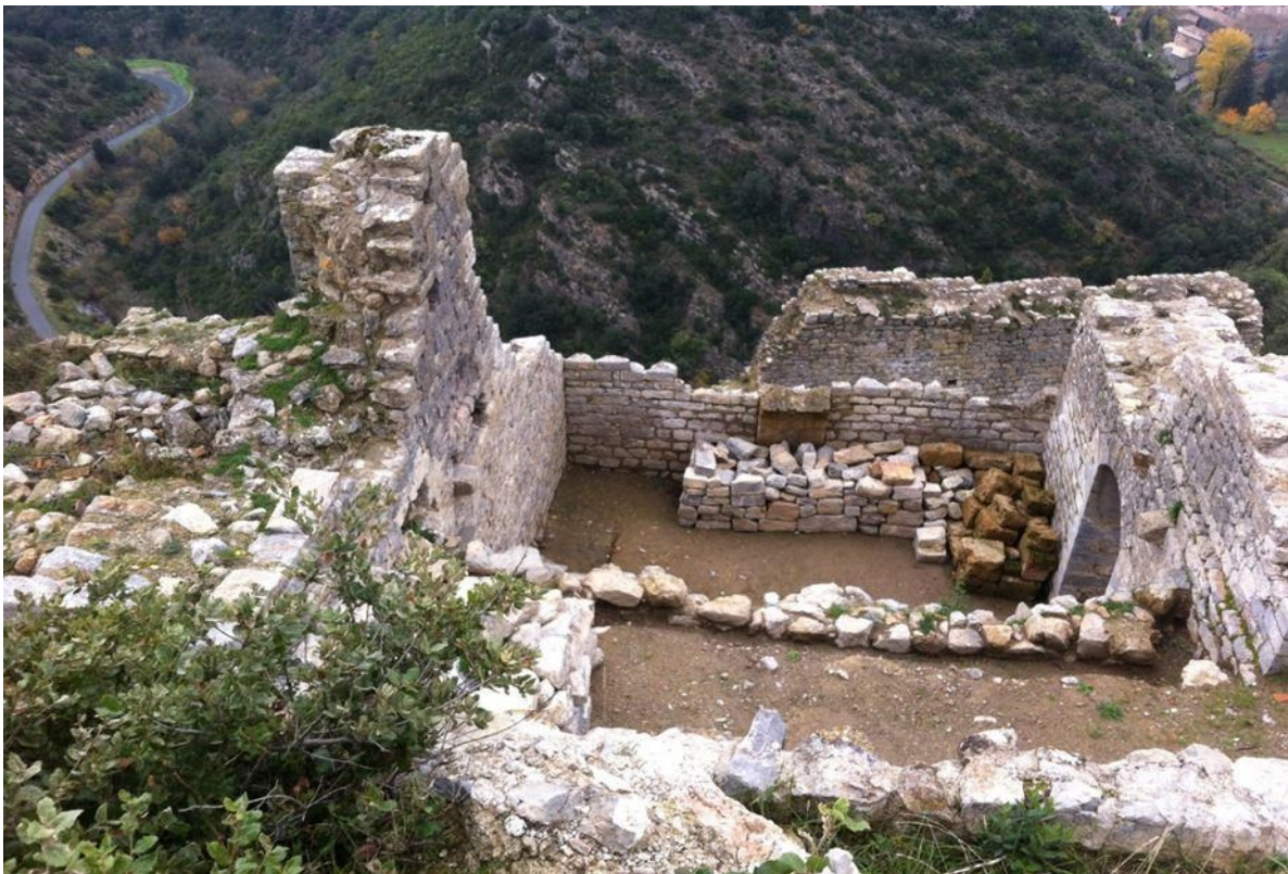
Figur 9 Fra Termes i Languedoc, Frankrike. I bakkant ses stabler av stein som møysommelig settes tilbake i muren der de antas å ha stått opprinnelig.
