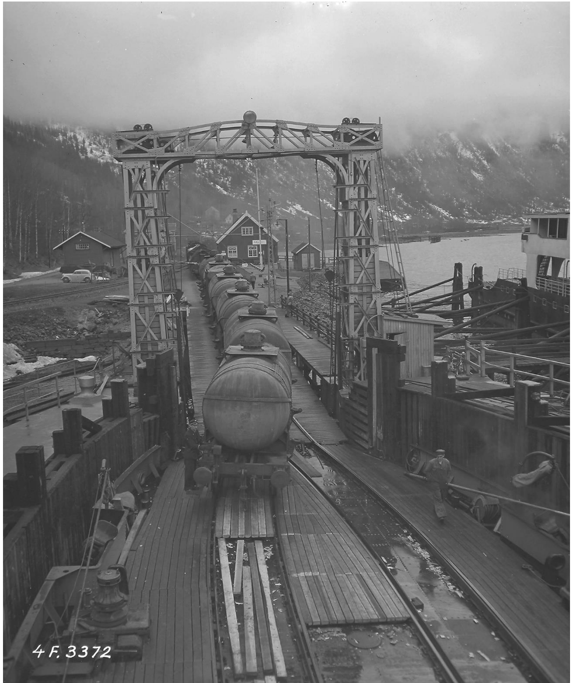
Figur 9: Tankvogner kjøres om bord ved fergeleiet på Mæl. Foto: Norsk Hydros fotosamling/NIA
