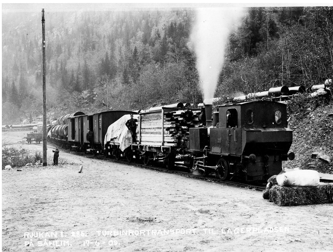
Figur 5: Turbinrørtransport til lagerplass på Såheim i 1909. Foto: NIA
