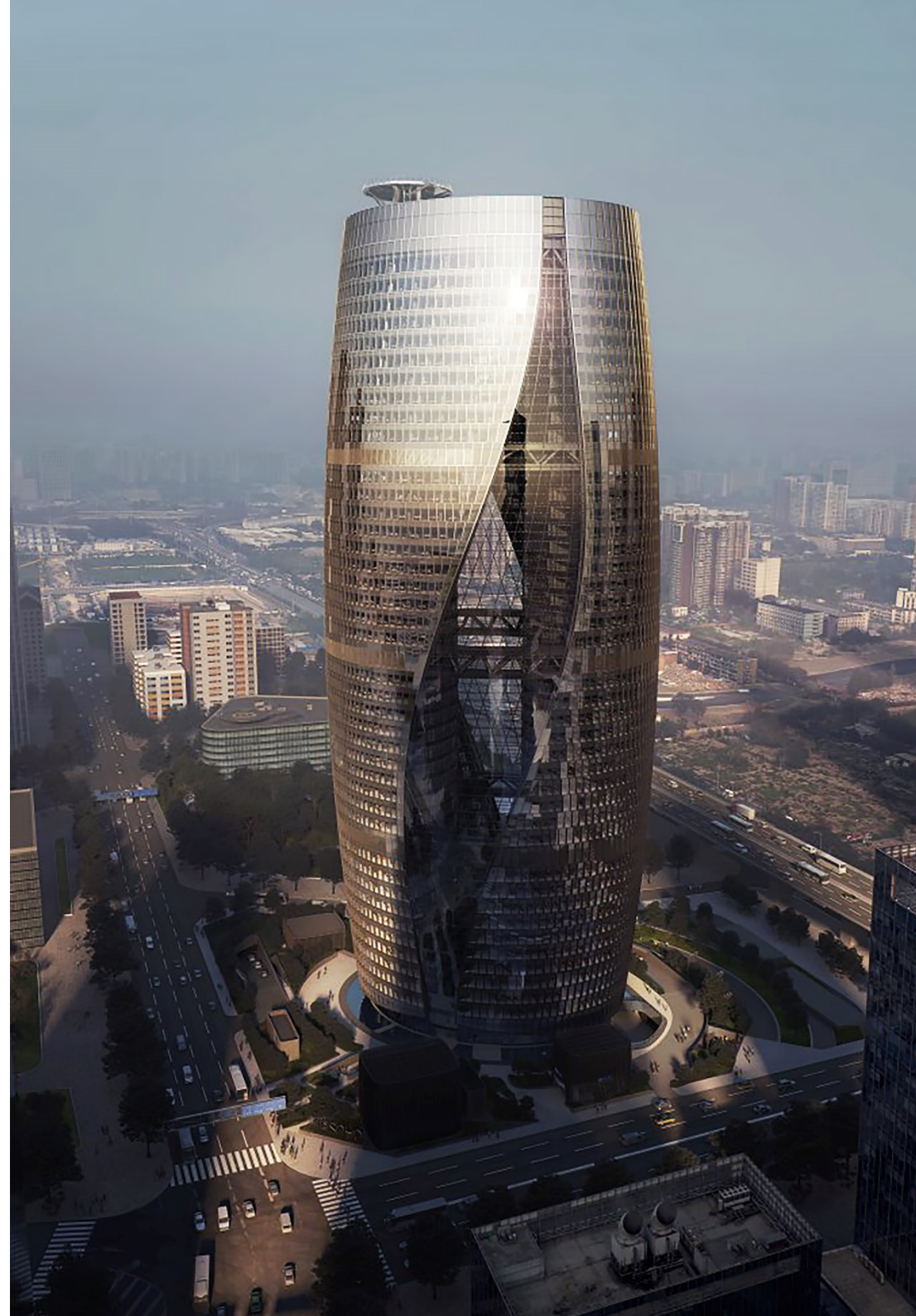
Figur 1 Verdens største atrium i Beijing, Cina Under konstruksjon, illustrasjon by; Leeza SOHO, Zaha Hadid Architacts
