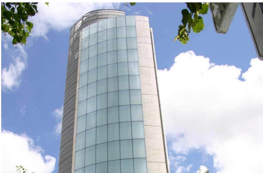
Figur 42: Fasade Hotel deregion Lille2 med opaliserende glassflater. Kan monteres både horisontalt og vertikalt. Levert av Pilkington, NSG Group. https://projects.pilkington.com/global/SearchResults.aspx?search_id=71864774
