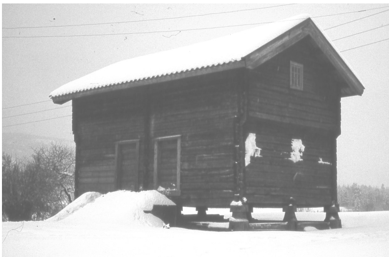
Loft frå Flåbygd i Lunde, Telemark. Av di lofta var læsbare og utan eldstad, var dei godt eigna til oppbevaring av verdisaker, m.a. viktige gardsbrev. Foto Sigrid Bø 1979.
