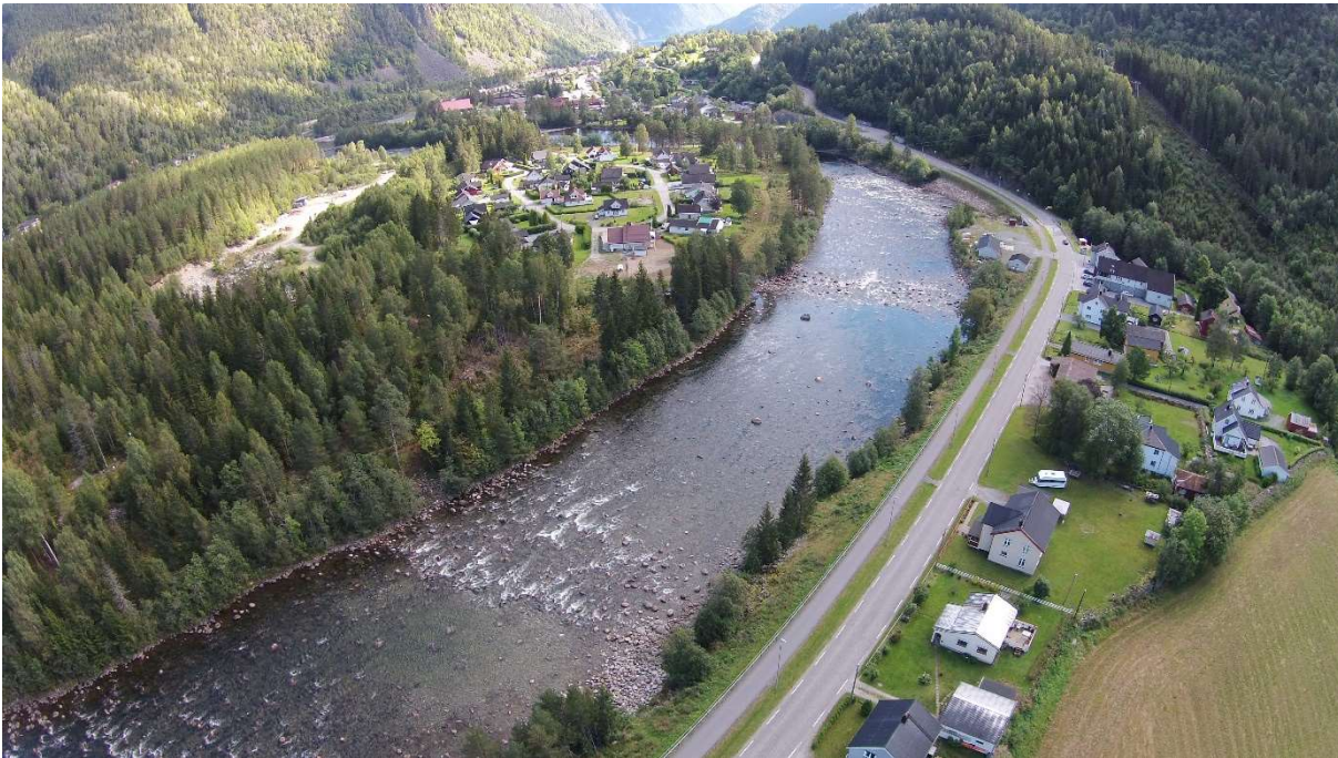
Figur 2.6. Gravearbeider nedstrøms Geishyl med utlegging av stor blokk (øverst) og ombygde terskel 1 og 2 med et utjevnet brekk/fall og mer strykhabitat (nederst). Foto: Statkraft.
