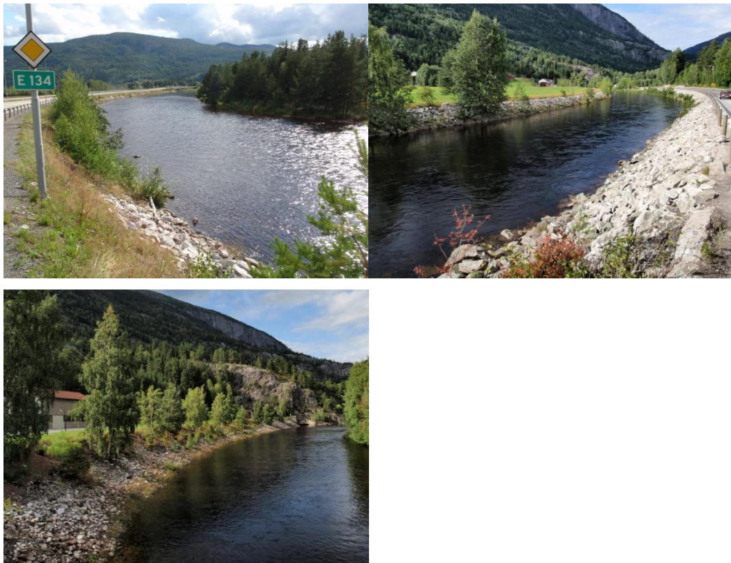
Figur 13. Vesentlige strekninger i Vallaråi har bratte elvebredder som følge av tidligere inngrep i forbindelse med veibyging og kanalisering ved Sundsbarm kraftverk.
