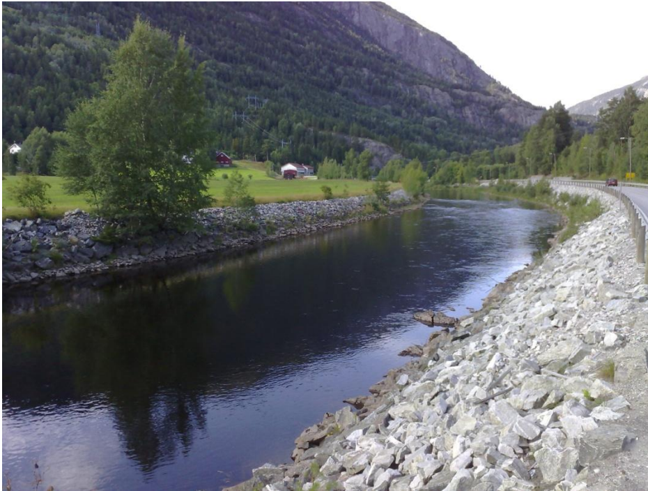
Figur 7. Kanalisering av elveløpet fra kraftverket og ca 0,5 km nedstrøms (øverst) og flytting og plassering av elveleiet i forbindelse med utvidelse av E 134 (nederst).
