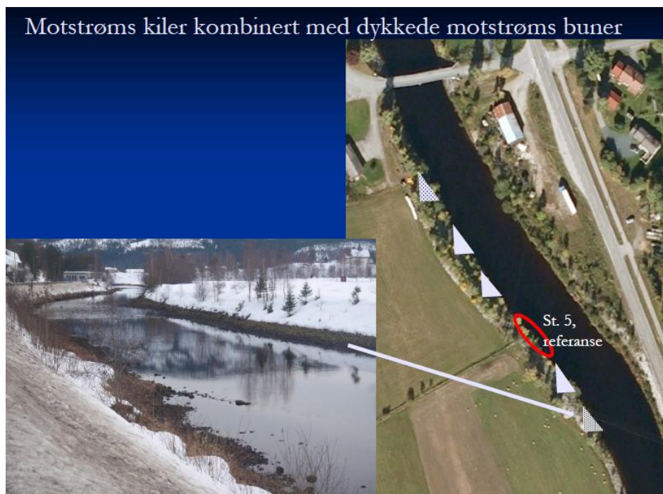
Figur 15. Vesentlige strekninger i Vallaråi har bratte, rettlinjede elvebredder som følge av tidligere inngrep. Mer elvekant og strukturell variasjon foreslås skapt ved bygging av motstrøms kiler kombinert med dykkede motstrøms buner.
