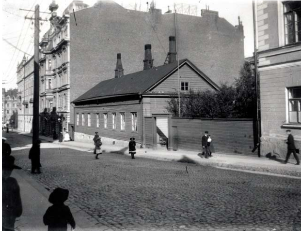
Kasärngatan 23 i Helsingfors sentrum. I dette trehuset bodde Hamsun den siste perioden. 201
